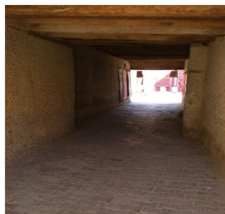
Photo 4. Long "bortal" (toiture soutenue avec des troncs de palmier)
